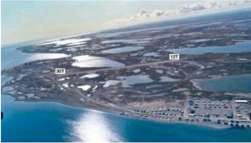
Photo 5-4 - Piste et communauté de Hall Beach, en regardant vers le sud-ouest source : Gouvernement du Nunavut, Gouvernement communautaire et Transports
