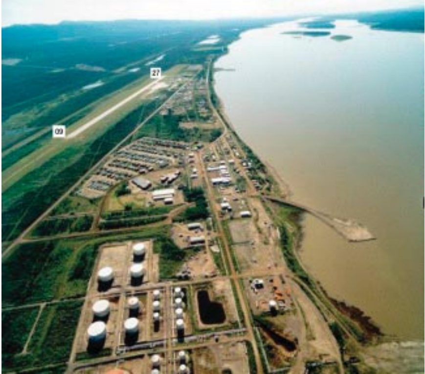
Photo 5-9 - Aéroport de Norman Wells, source: Pryde Schropp McComb Inc. en regardant vers l'est
