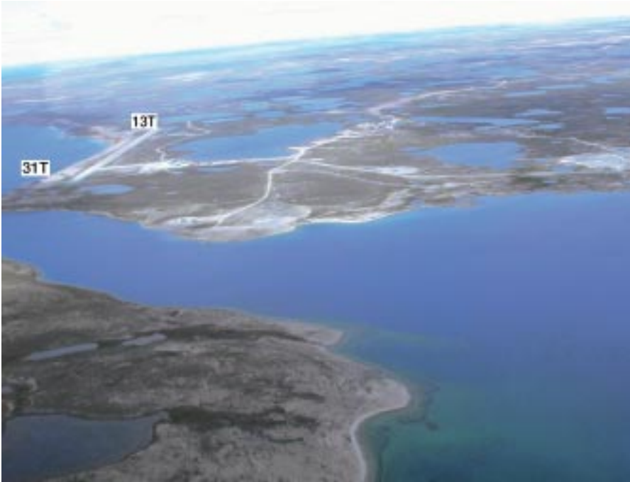
Photo 5-14 - Aéroport de Cambridge Bay, en regardant vers le nord-ouest
